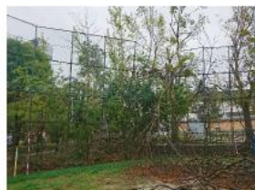
公園施設の被害状況（天王寺区：生玉公園）
