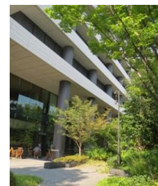
■総合設計制度による公開空地 (新ダイビル 堂島の杜)〔出典 38〕
