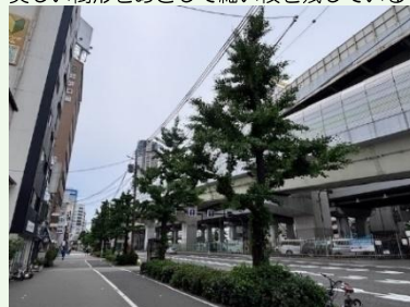
写真 現在（2025（令和7）年）
