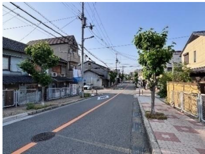
写真 花木通り（城東区城運橋筋）
