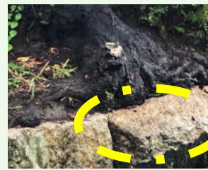
写真 根が擁壁を押している状況 （将来、擁壁が損壊するおそれあり）
