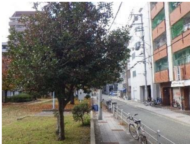
写真 架空線に干渉している樹木
