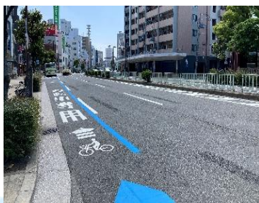
緊急対策整備区間の整備 国道172号（みなと通）
