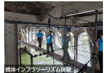
橋体インフラツーリズム体験
