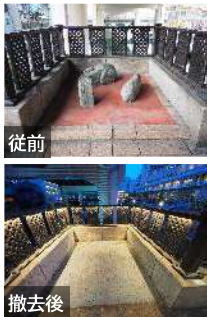
バルコニー部の石材撤去
