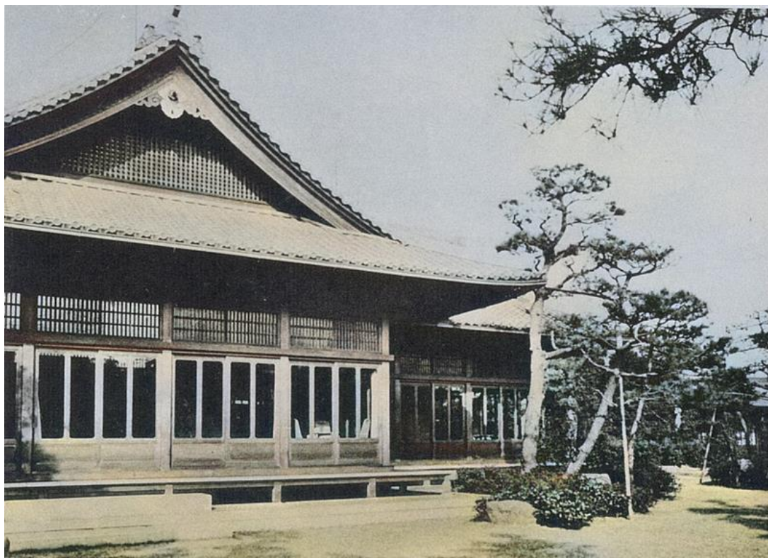
図 洋館邸南側外観
