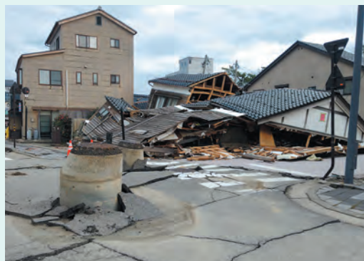
家屋の倒壊と液状化で隆起したマンホール
