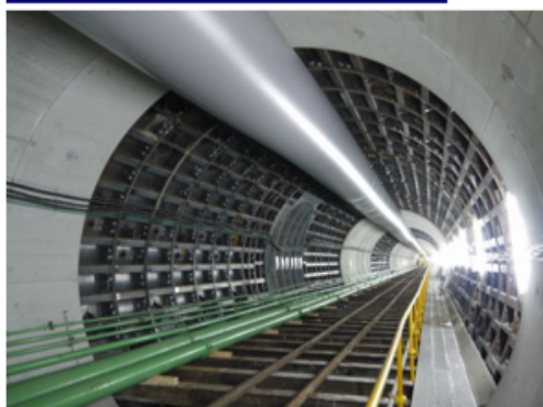
北浜逢坂貯留管（直径 6m、長さ 約4.8km）
