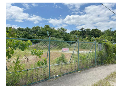
④北西側敷地境界を見る
