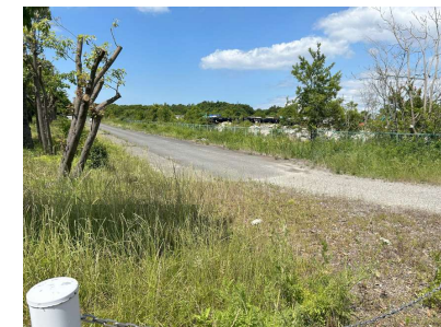
②南東敷地出入口付近を見る
