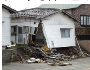
▲熊本地震で倒壊した家屋
