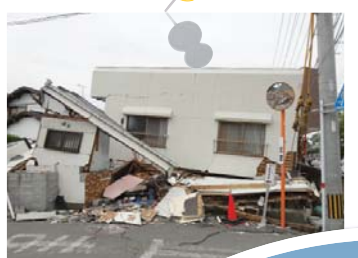
▲益城町家屋被害の様子
