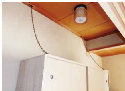
▲ 転倒防止器具取付け後の家具
