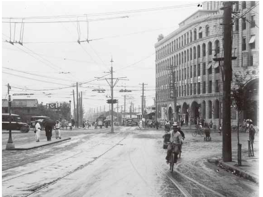
▲昭和初期、上六交差点の風景。写真右の大軌ビルは近代日本を代表する建築家の一人、武田五一の設計。地下1階から地上3階には三笠屋百貨店が入居していた。入り口付近には多くの女性の姿が見られる。(大阪城天守閣所蔵古写真より)
