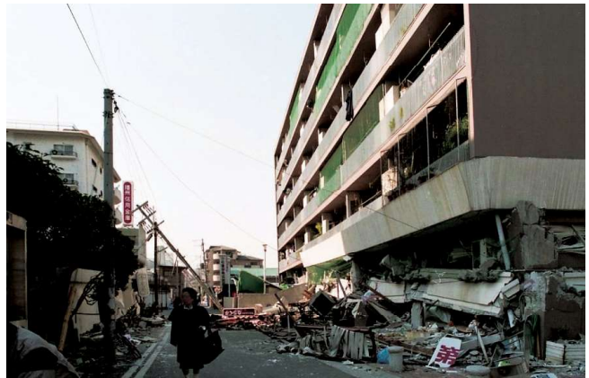
低層階の崩落、壁等の著しい損傷
