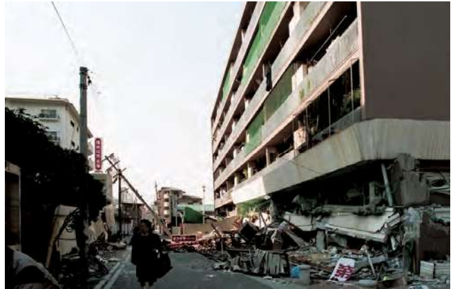
低層階の崩落、壁等の著しい損傷
