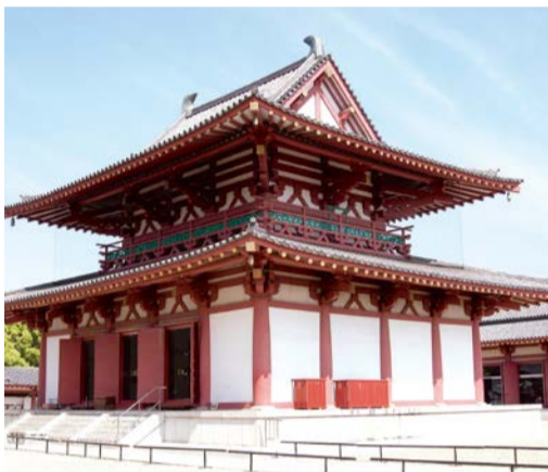
和宗 総本山 四天王寺 金堂再建工事(天王寺区)
