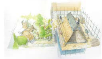
茅屋根葺き替え作業風景
