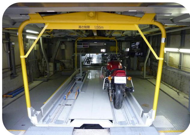
機械式駐車装置のパレットに 自動二輪車固定スライダーパレットを2台設置
