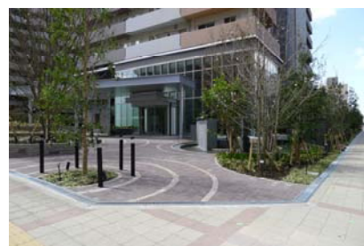
□幹線道路沿いの空地
