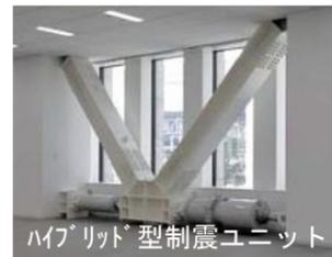
制震装置は装置の両端に生じる軸変形を回転運動に変換することで得られる質量効果を利用した回転慣性質量ダンパーとオイルダンパーを組み込んだ「ハイブリッド型制震ユニット」を採用している。
