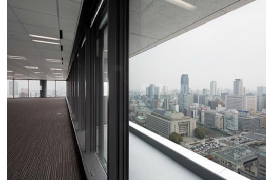
深い庇で日射から守られたフルハイトの窓から、中之島・御堂筋をプラインドレスで俯瞰する。
