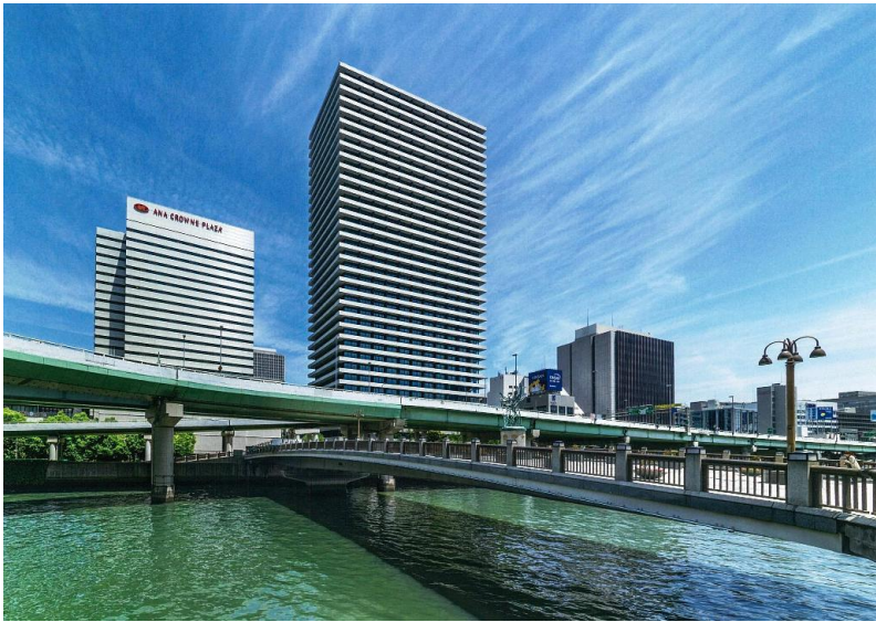
重厚な石張りの外装は川を挟んだ中之島の建築物群と呼应し、横基調のデザインは隣接する堂島ダイビル（ANA クラウンプラザホテル大阪）と呼应する。ビルとしてのアイデンティティを表出しつつ、周辺環境との連続性を意識した外観とした。
