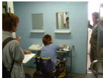
車いす対応型トイレがない(例)
