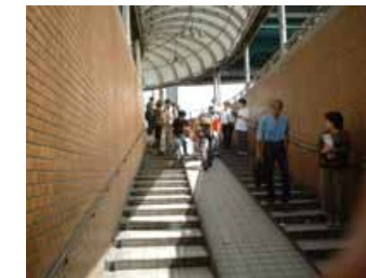
長い斜路が続く地下道(例)
