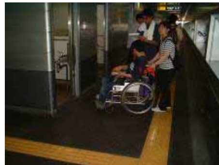
視覚障害者誘導用ブロックが トイレまで誘導できていない
