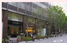
素材や意匠の切り替えにより低層部と中高層部を分節している例
