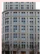
独立窓とし陰影を創り出している例
