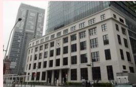
中層部と高層部で意匠を切り換えている例
