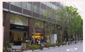
素材や意匠の切り替えにより低層部と中高層部を分節している例
