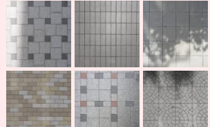
東西方向道路の舗装材・舗装パターンの違い
