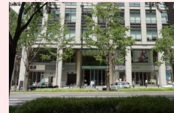
1階と2階に店舗等を設けている例
