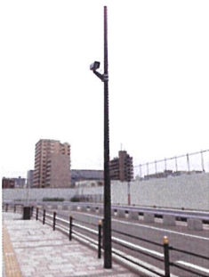
□設置状況(固定型)
