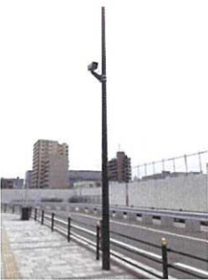
□設置状況(固定型)
