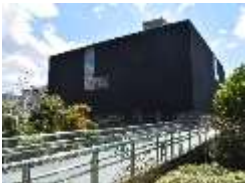
大阪中之島美術館と周辺施設をつなぐ歩行者デッキ整備
