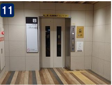
④地下1階部分のEVで、大阪メトロ御堂筋線西改札につながる
