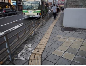
C. 誘導ブロックは敷設されているが、歩道が狭い
