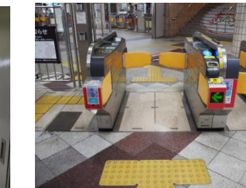
15 谷町線南改札へ (構内からの写真)
