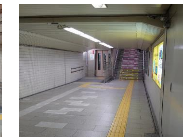
⑭ 谷町線南改札への通路 視覚障がい者誘導用ブロック は敷設されている
