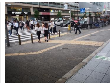
⑦ JR天王寺東口前の歩道 車道方向に勾配あり
