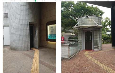
地上につながるエレベーター
