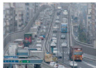
阪神高速 東大阪線(高井田付近)
