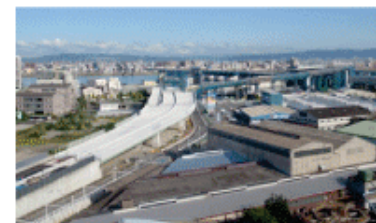
阪神高速 淀川左岸線1期工事(高見工区)
