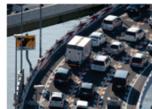
阪神高速 守口線・環状線合流部
