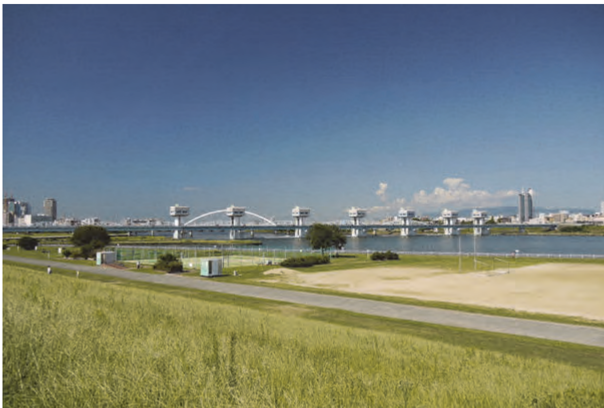
写真 8-16-1 (6) 淀川河川公園 毛馬地区からの眺望の状況の変化
