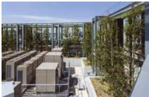
壁面を最上階から1層分立ち上げ、さらに内側に植栽を施すことで建築設備等を修景している例。
