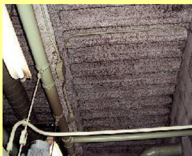
天井断熱材(天井、壁吸音材)
