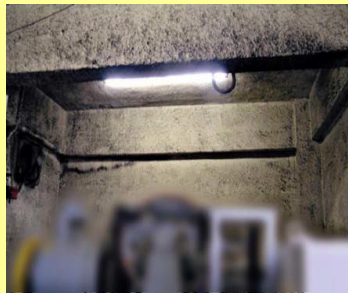
機械室吸音材
