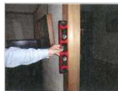
水平器による柱の傾きの計測
