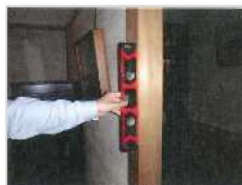
水平器による柱の傾きの計測
