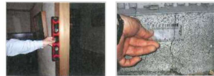
水平器による柱の傾きの計測
