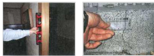
水平器による柱の傾きの計測
