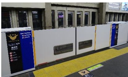
京橋駅 (高さ：約 1.3m、最大開口：約 4.5m)
