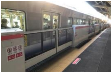
京橋駅 (高さ：約 1.3m、最大開口：約 3.5m)
