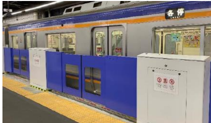
難波駅 (高さ：約 1.3m、最大開口：約 3.5m)
