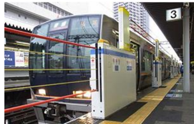
大阪駅 (高さ：約 1.3m、最大開口：約 13m)
