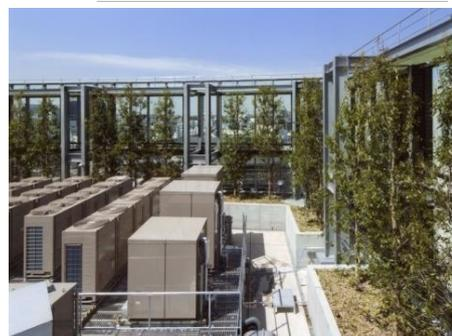
壁面を最上階から1層分立ち上げ、さらに内側に植栽を施すことで建築設備等を修景している例
