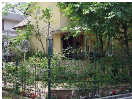
敷地際の緑と合わせてデザインされた透過性のある柵としている例
