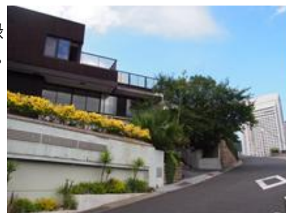
敷地際の緑化により圧迫感を軽減した例
