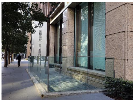
透明のガラスで排気エリアを覆っている例
