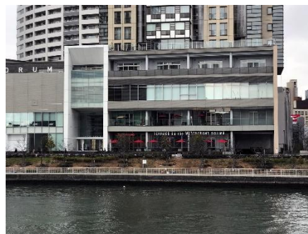
河川側にテラスを設けている例
