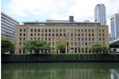
沿川建物を引き立てる護岸のデザイン
