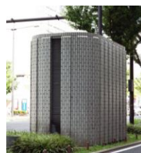
換気塔・吸気塔
