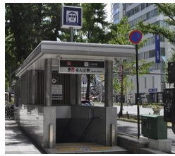
地下出入口上屋
