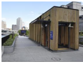
地下鉄出入口上屋
