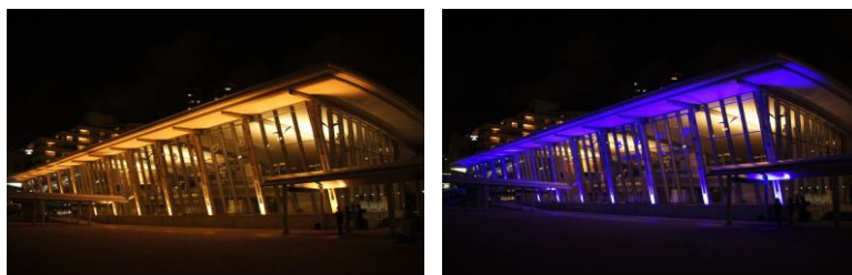
中央堤中央ターミナル・かもめりあ（神戸市）※3
