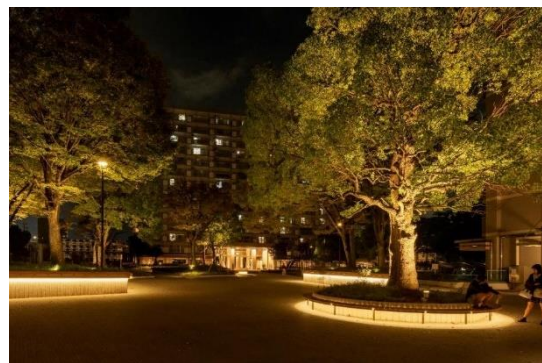
写真 2) 従後) 色温度を電球色（3000K）で統一し、樹木のライトアップなど目に見える鉛直面に間接照明を入れ「明るさ感」が高められた事例
