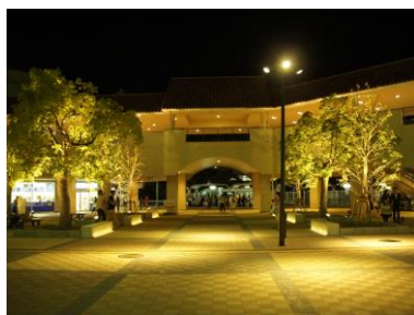
歩行者動線の路面を照らす歩行者用照明例 ※3
