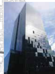
⑨ 大阪富国生命ビル建替
