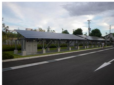
(太陽光パネル)
