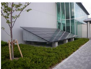
(太陽光パネル)
