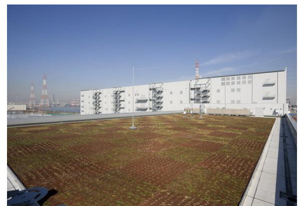
(ボリュームのある屋上緑化)
