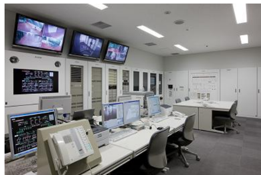
(防災センター)
