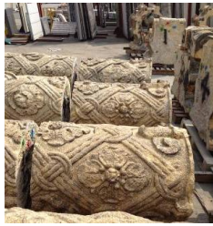
基壇部石材1ピースずつ 取外し再利用
