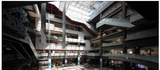
上/北館「ナレッジプラザ」は天 空光による自然採光、テナン ト空調排気再利用、居住域空 調、トップライト排気（夏）、 同デリバントファンによる暖 気吹下し（冬）を行っている。
