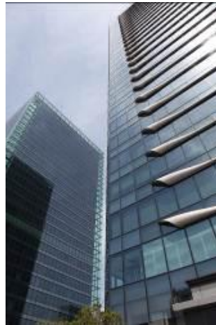
左/タワーAのエアインテイク（採風口。ここから外 気を室内に導入・排出するクロスベンチレーシ ョンタイプの自然換気システムを導入している）の 外観とタワーBのコーナーボイドの外観
