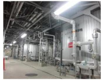
バイオガス設備(メタン発酵槽)
